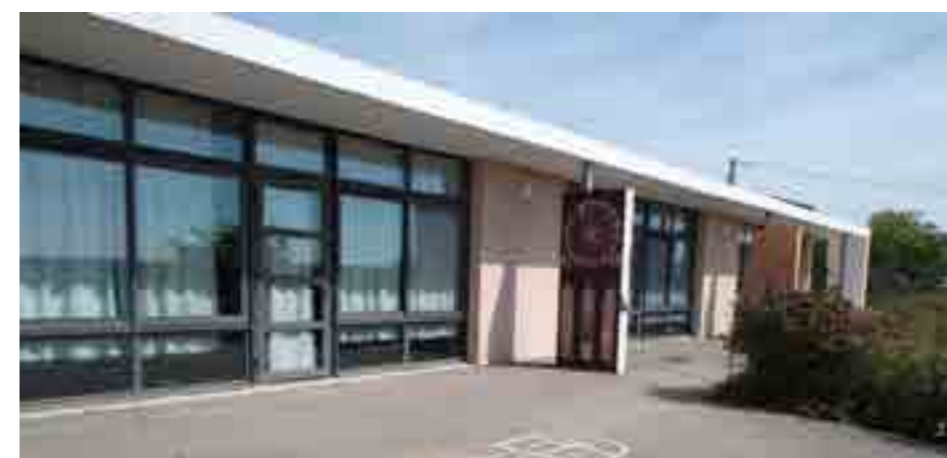
Des classes «effet de serre» : L'école primaire de Viols-le-Fort se compose, dans sa longueur, d'une façade de baies vitrées qui donnent directement dans les classes. Pendant trois mois, soit un tiers de l'année, le climat de la classe est suffoquant. Parfois, les enfants sont encouragés à garder sur leur front un tissu mouillé...
